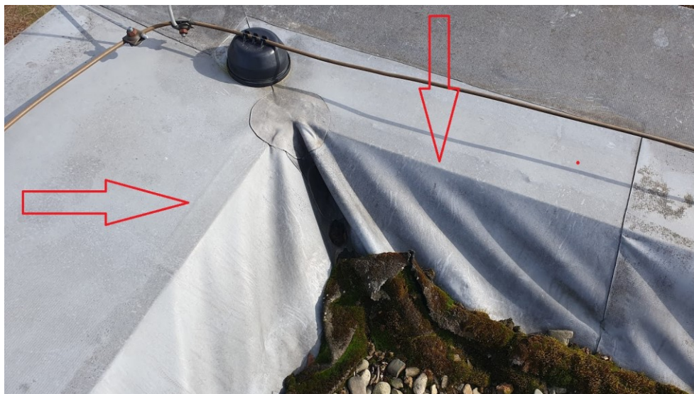
Obrázek č. 2 – deformace folie PVC od atikové konstrukce
