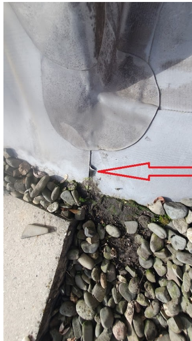
Obrázek č. 10,11 – Oddělení klempířských prvků, deformace folie a protržení folie
