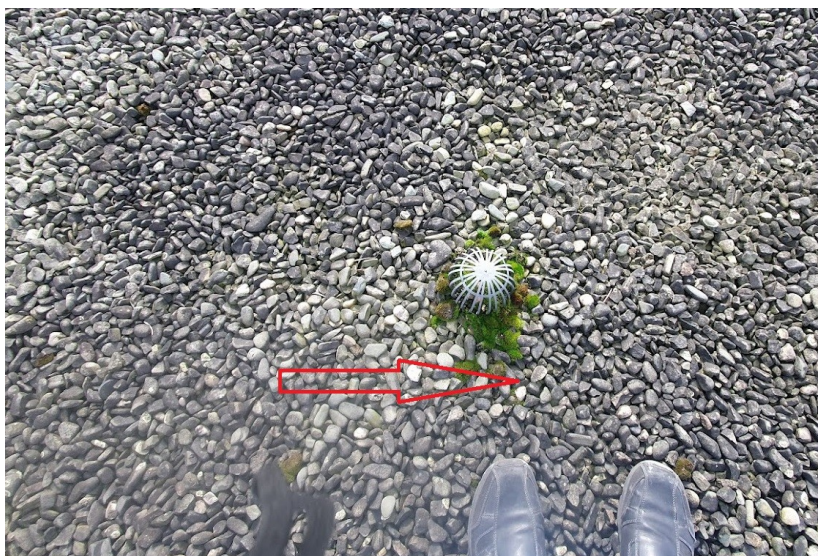
Obrázek č. 8 – Pohled na střešní vpust a zamechování ploch
