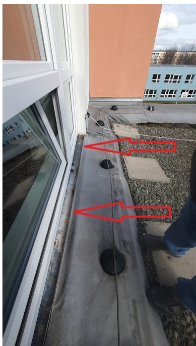
Obrázek č. 10,11 – Oddělení klempířských prvků, deformace folie a protržení folie
